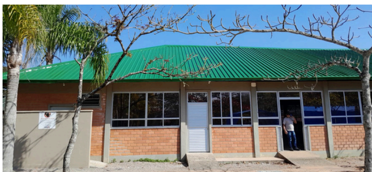
TELHADO DO CAMPING
